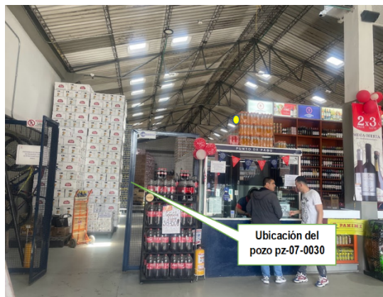
Foto No. 2. Vista general de la ubicación del pozo
