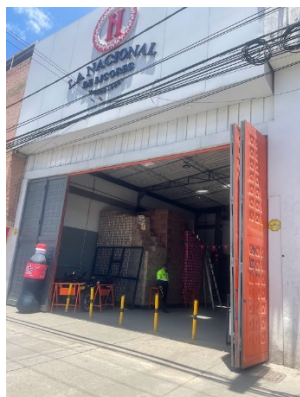
Foto No. 1. Fachada del establecimiento
